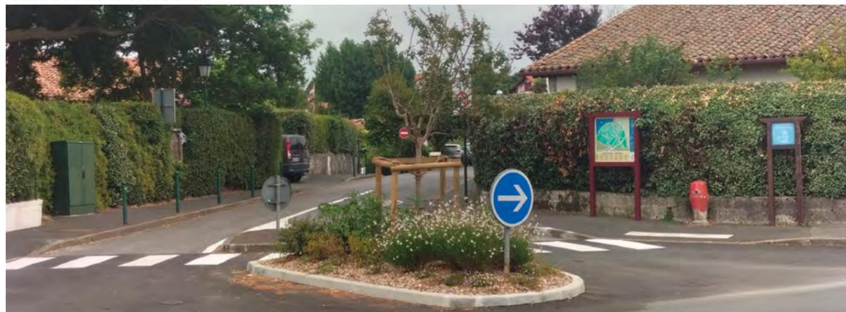
Suite aux dégradations de voirie engendrées par le pin situé dans l'îlot d'entrée, celui-ci a été supprimé, le carrefour refait avec la voirie et le marquage. Une nouvelle essence moins impactante installée avec un parterre fleuri.
