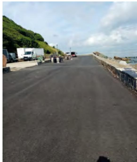
Suite à ces travaux, le sol de la jetée des Alcyons, en partie dégradé, a reçu un nouvel enrobé et les différents murets sont également en phase de restauration.
