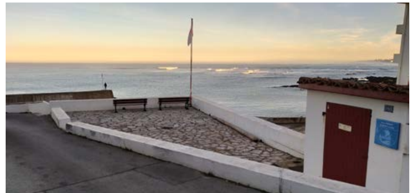
Rénovation de la place XIMIST (Maçonnerie, étanchéité et pose de pierre) qui sera réalisée en ce début d'année.
