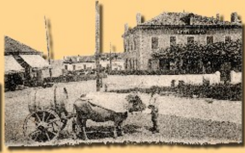
Le café de Madrid (1885) et l'hôtel Juzan (1864) Madrid ostatua (1885) eta Juzan hotela (1864)
