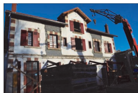
Chantier de l'ancienne école primaire
