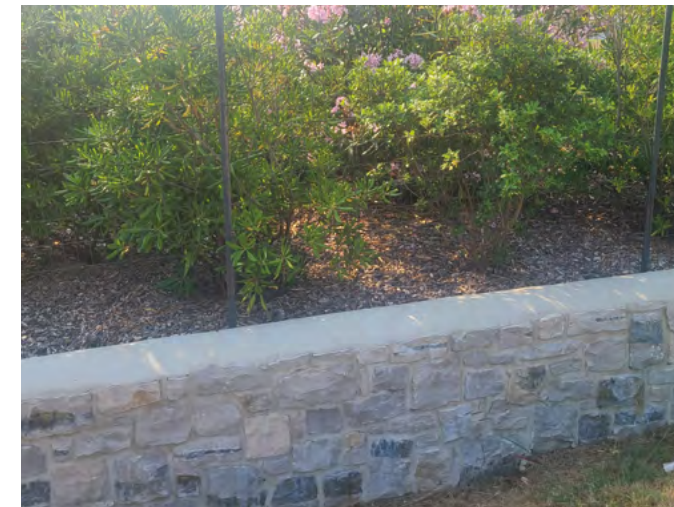
Quelques exemples de clôture qui respectent le PLU
